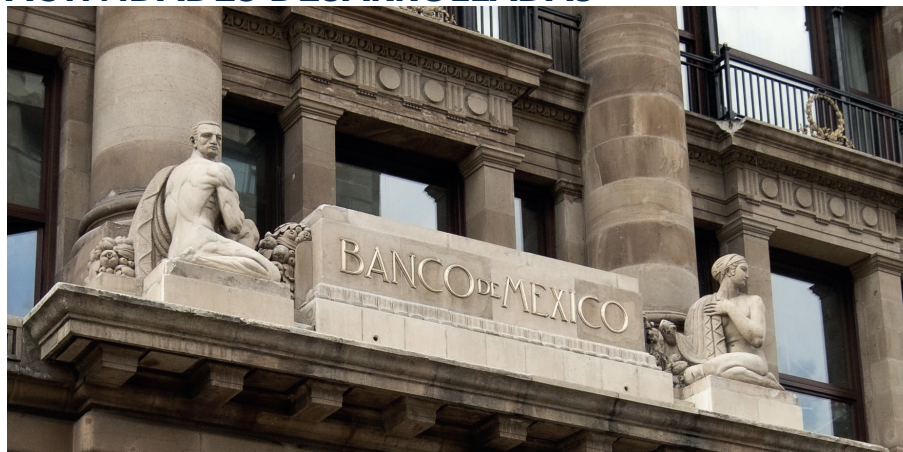
Edificio Principal de Banco de México en el Centro Histórico de la Ciudad de México
